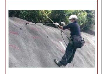
シリカリ塗布状況(法面ひび割れ防止、止水)
