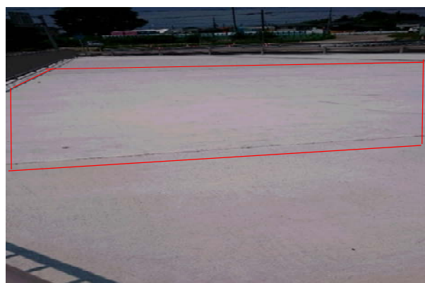
③未塗布面のひび割れ
