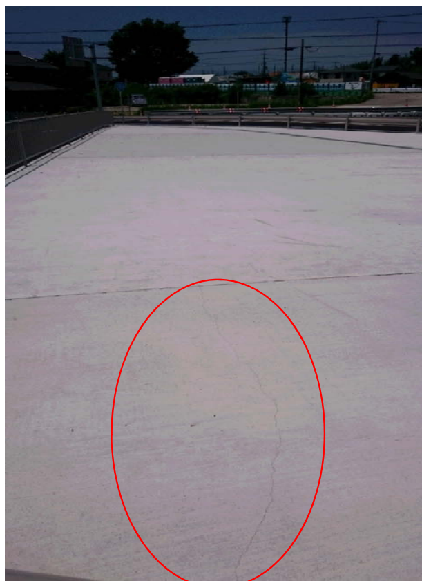
③未塗布面のひび割れ
