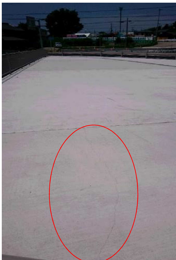
③未塗布面のひび割れ
