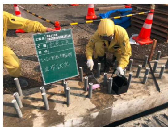
②ひび割れ部にローラーを使って、シリカを塗布
