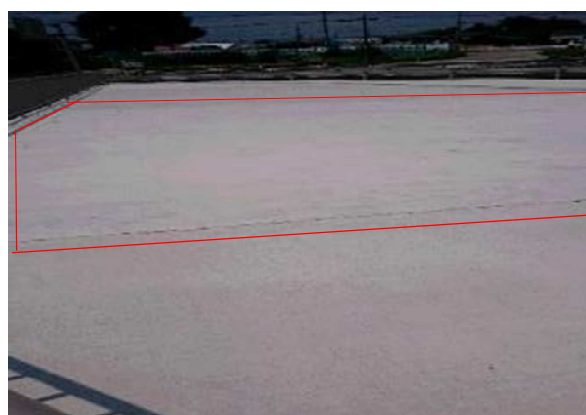
③未塗布面のひび割れ
