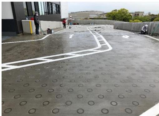
店舗（鉄鋼造）の屋上デッキコンクリートのひび割れ抑止、防水（10年保証）
