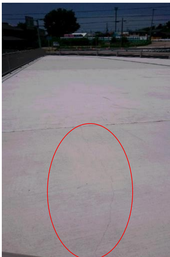
③未塗布面のひび割れ
