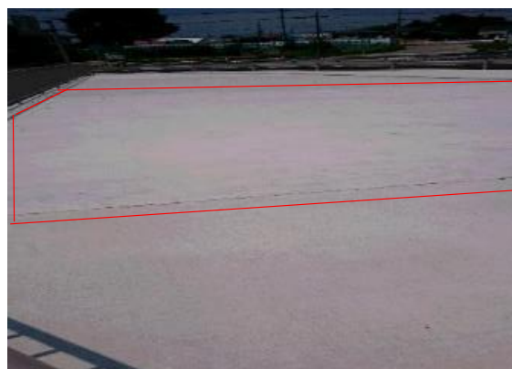
③未塗布面のひび割れ
