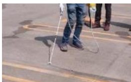
ひび割れ部にシリカリを重点注入
