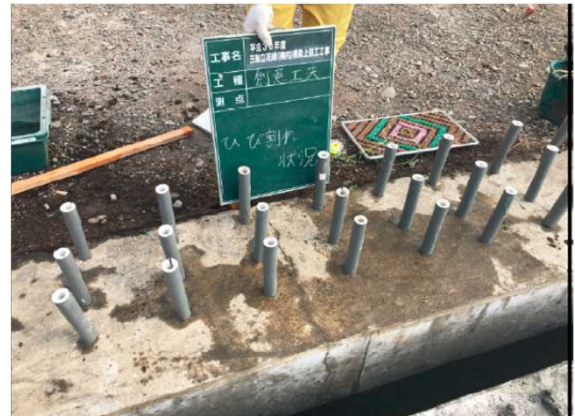
②ひび割れ部にローラーを使って、シリカリを塗布
