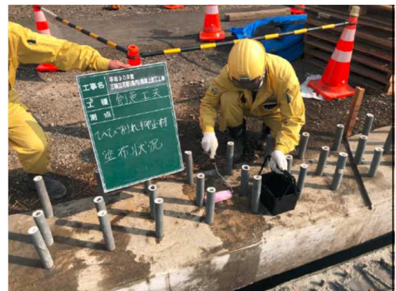
②ひび割れ部にローラーを使って、シリカリを塗布
