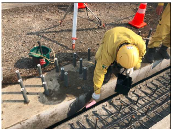
②ひび割れ部にローラーを使って、シリカリを塗布
