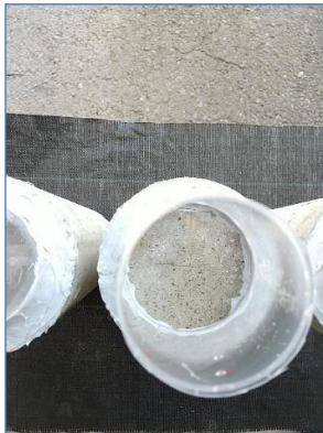
T-④ 注水分が残る
