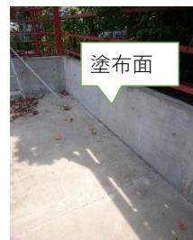
（実コンで現場透水量試験実施）
