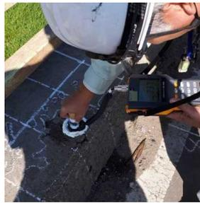
写真4 電気抵抗式水分計による測定状況
