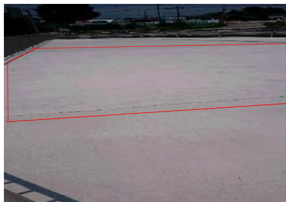
③未塗布面のひび割れ
