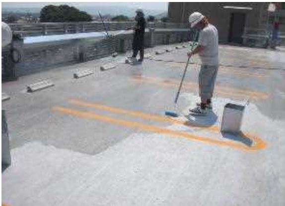
③表面のヌメリや残材を、たっぷり散水しながら、デッキブラシで除去洗浄して完了
