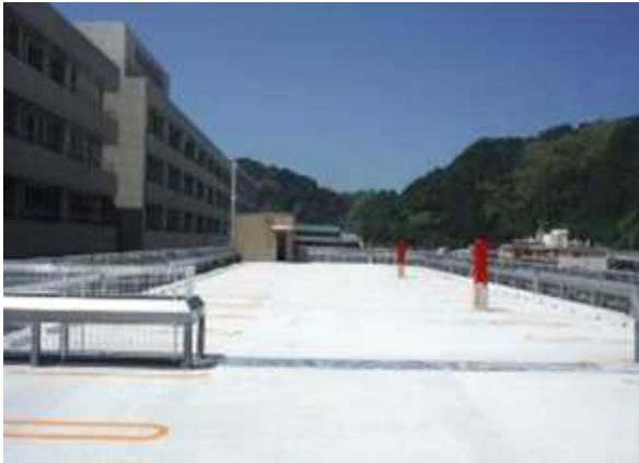
②飛散抑止のため、ローラーを使って、シッカリート改質用を塗布
