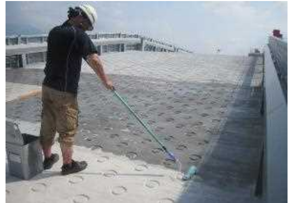
③表面のヌメリや残材を、たっぷり散水しながら、デッキブラシで除去洗浄して完了
