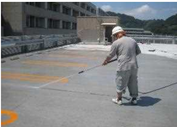
③表面のヌメリや残材を、たっぷり散水しながら、デッキブラシで除去洗浄して完了
