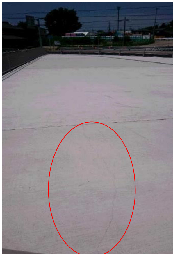
③未塗布面のひび割れ
