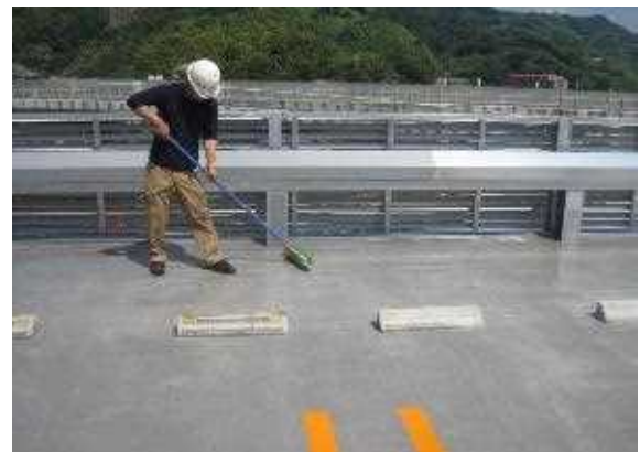
③表面のヌメリや残材を、たっぷり散水しながら、デッキブラシで除去洗浄して完了
