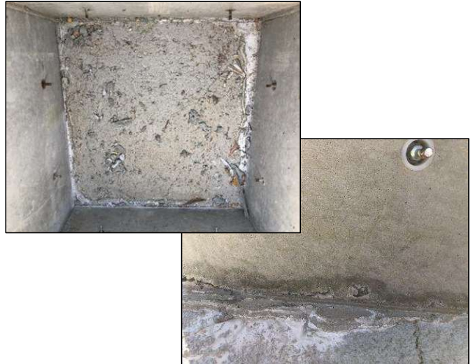
左上図：マスの底部（上から撮影） 右下図：底板部入隅部
