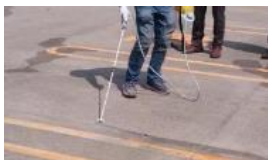
ひび割れ部にシリカリを重点注入
