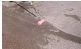
押さえコンクリートにシリカリを塗布
